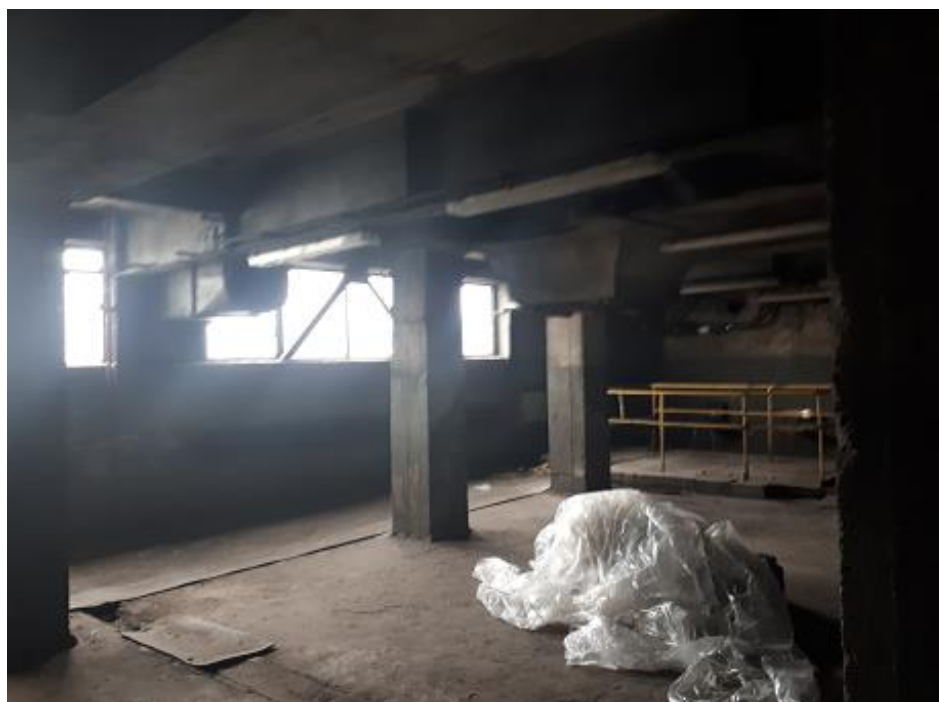
Rysunek 12. Budynek istniejącej kotłowni węglowej- poziom odzūżlania
