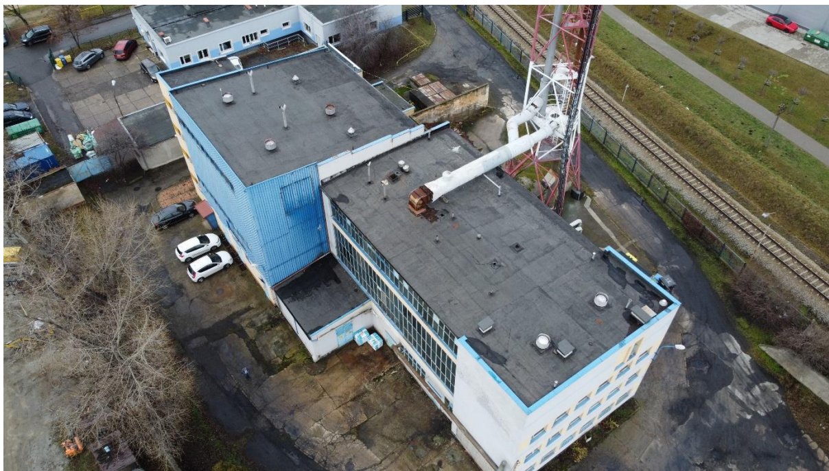
Rysunek 3. Budynek kotłowni – widok z góry
