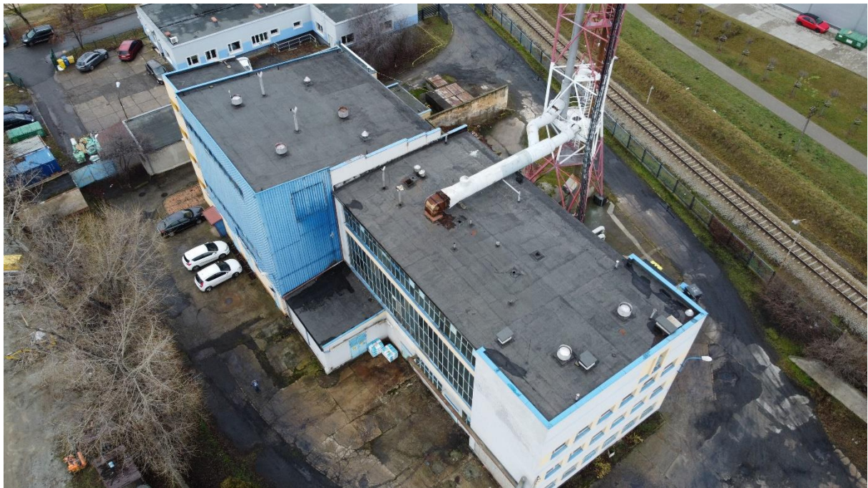
Rysunek 10. Widok z góry kotłowni
