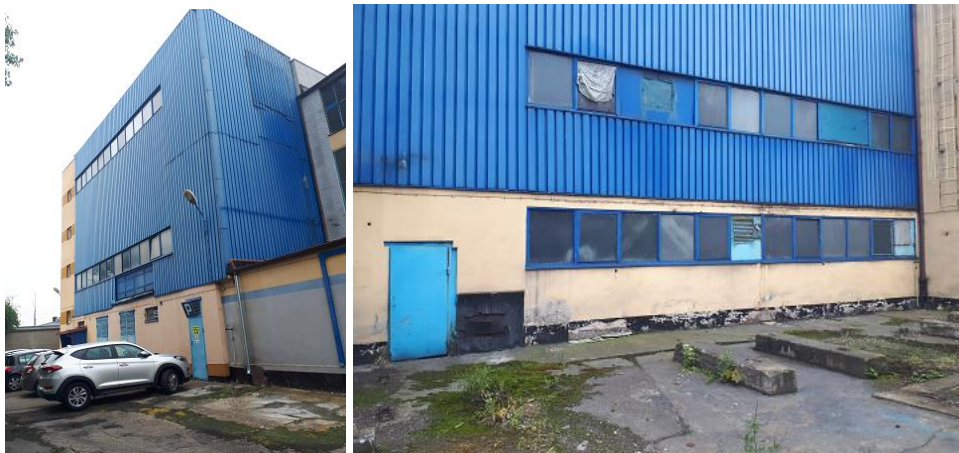
Rysunek 4. Budynek istniejącej kotłowni
