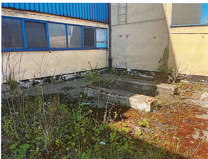
Fot. 1 Planowana lokalizacja wykonania otworu OW1
