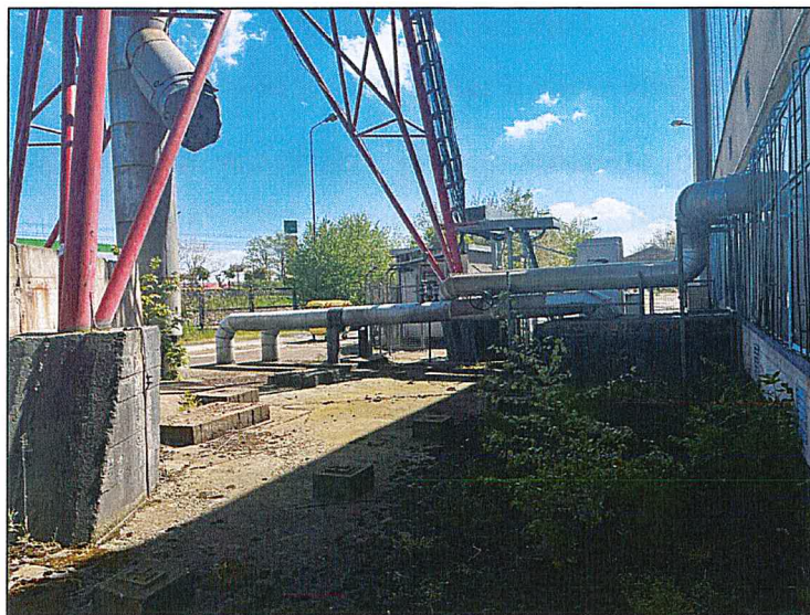
Fot. 3 Infrastruktura naziemna uniemożliwiająca dojazd wiertnicą do planowanej lokalizacji otworu OW1
