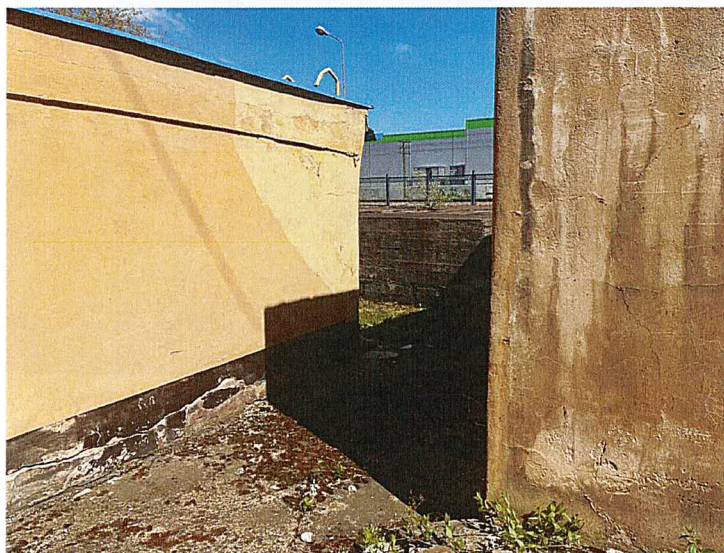
Fot. 4 Uniemożliwiony dojazd wiertnicą do planowanego miejsca wykonania otworu OW1
